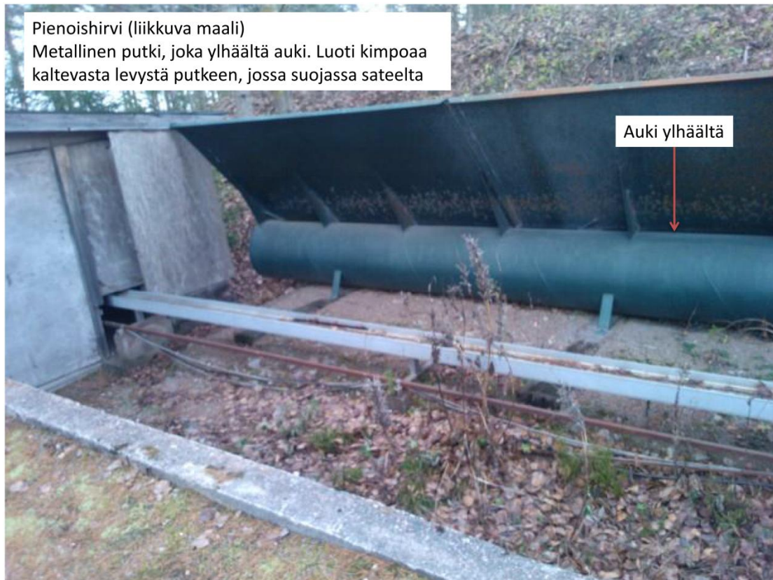
Kuva 14-2. Hirvi- ja villikarjuradoille soveltuva luotiloukkumalli.
