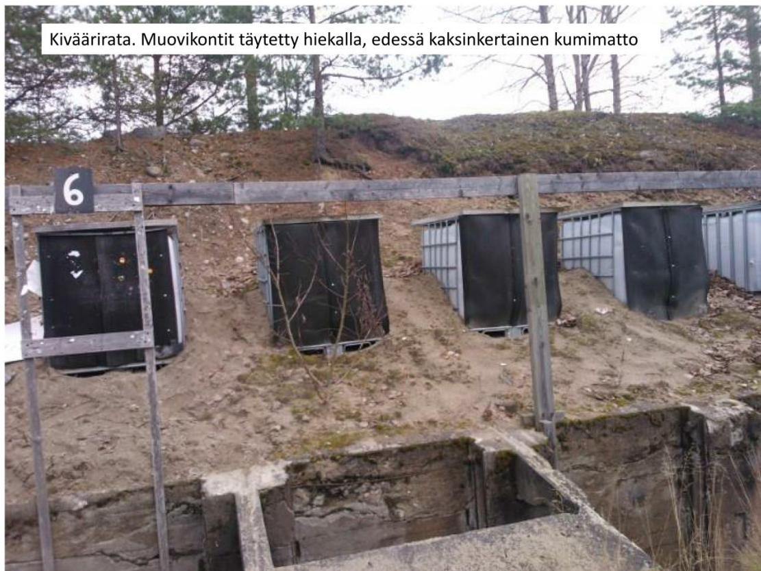
Kuva 14-1. Kivääriradan taustavallissa hiekkatäytteinen muovikontti luotiloukkuna.
