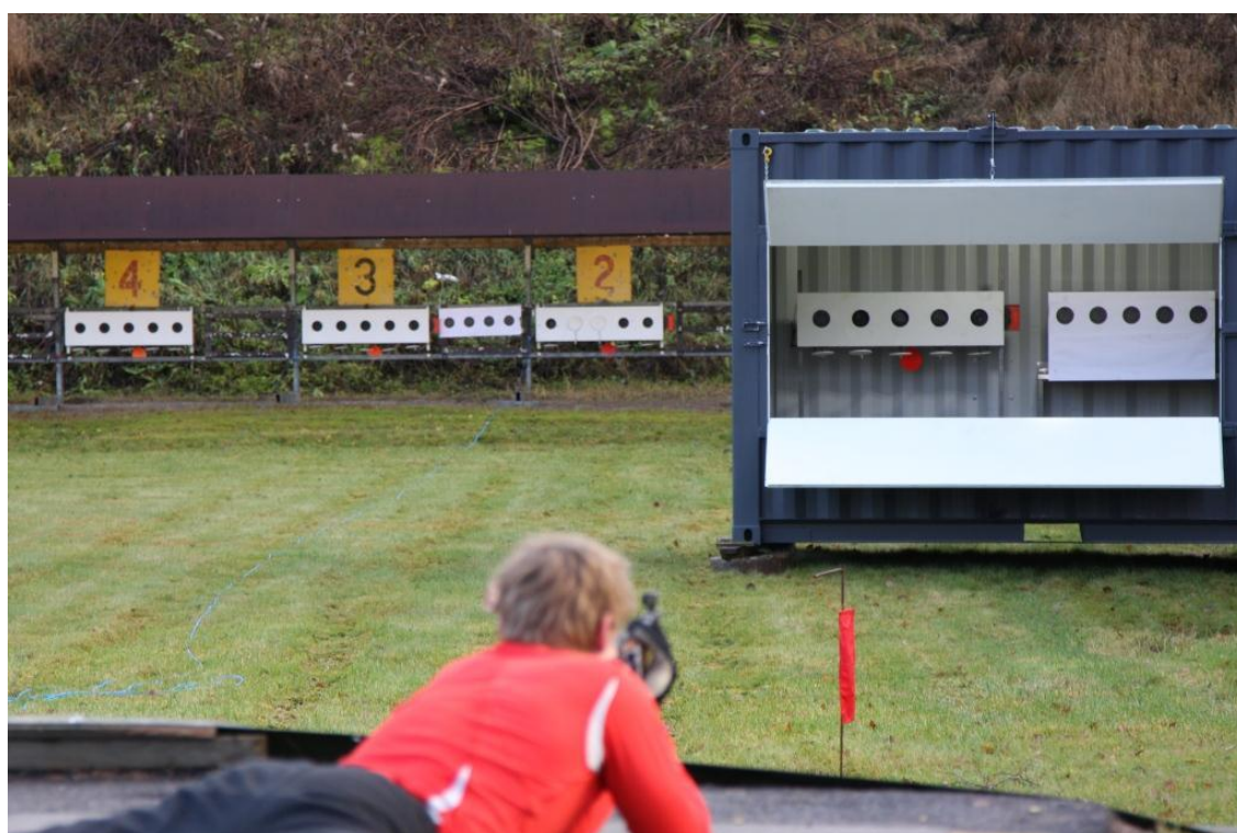
Kuva 14-7. Merikontti toimii ampumaradalla luotiloukkuna. Merikontin sisälle on asennettu ampumataulut.
