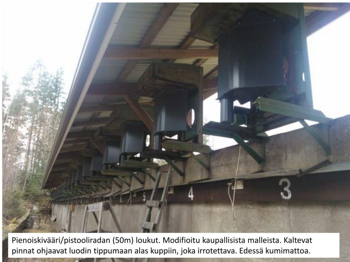
Kuva 14-3. Pienoiskivääri/pistooliradan luotiloukkumalli.
